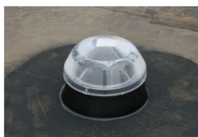
Obr. 2 – Systém Solatube 290 DS na rovné střeše
