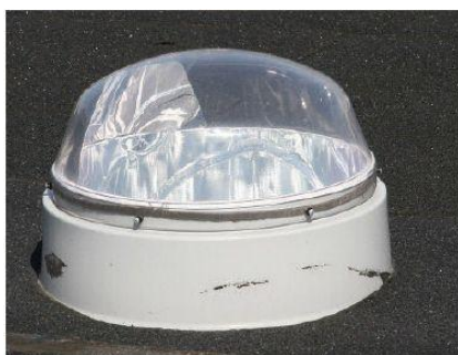
Obr. 25 – Systém 330-DS-O s čirou kopulí a reflektorem LightTracker™
